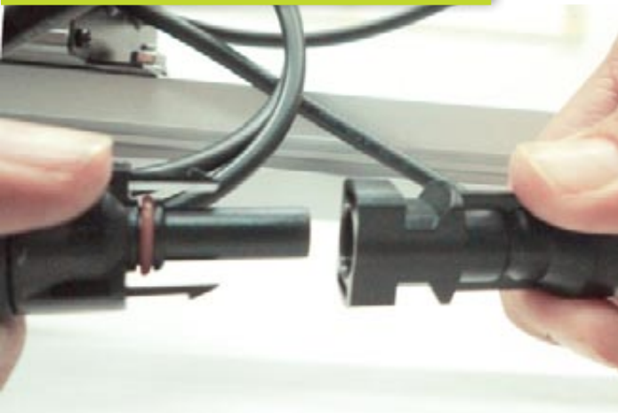
5. Conecta la caja y el inversor
